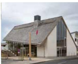
Le nouveau pôle multiservices de la commune de Folligny est un exemple remarquable d'écoconstruction, tant sur le choix des matériaux que sur la conception même du bâtiment. Construit à partir de ressources locales, cet ouvrage fait la part belle à l'architecture bioclimatique et la démarche low-tech : ossature bois isolée en bottes de paille, cloisons en briques de terre crue, enduits terre et chaux, couverture en bardeaux de châtaignier ...
